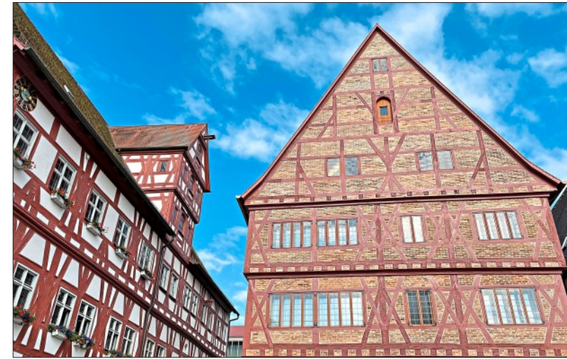
Mit viel Aufwand wurde das alte Gebäude und gleichzeitig Haupthaus des heutigen Hotels Krone im Herzen von Oettingen denkmalgerecht saniert. – Fotos: Hotel Krone
