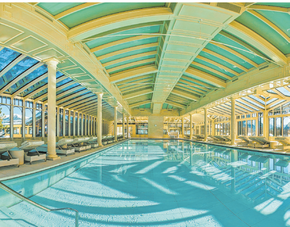
Das neue Schwimmbad beeindruckt mit seiner Stahl- und Glaskonstruktion. Foto: Der Wiesenhof
